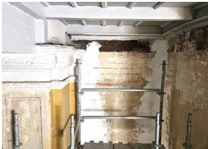
Anche sui pilastri sono in recupero altre decorazioni
