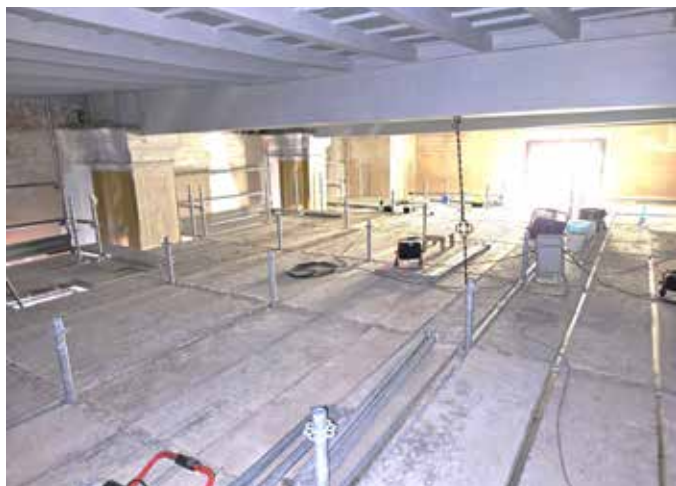
L'impalcatura di servizio che ha permesso la riverniciatura del soffitto
