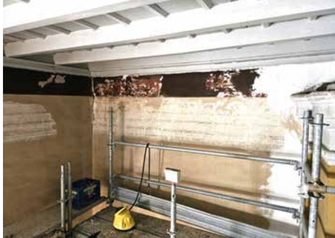
Nell'immagine a sinistra la zona dell'altare e del coro completamente terminata, sopra il particolare del ripristino della fascia sulle pareti laterali
