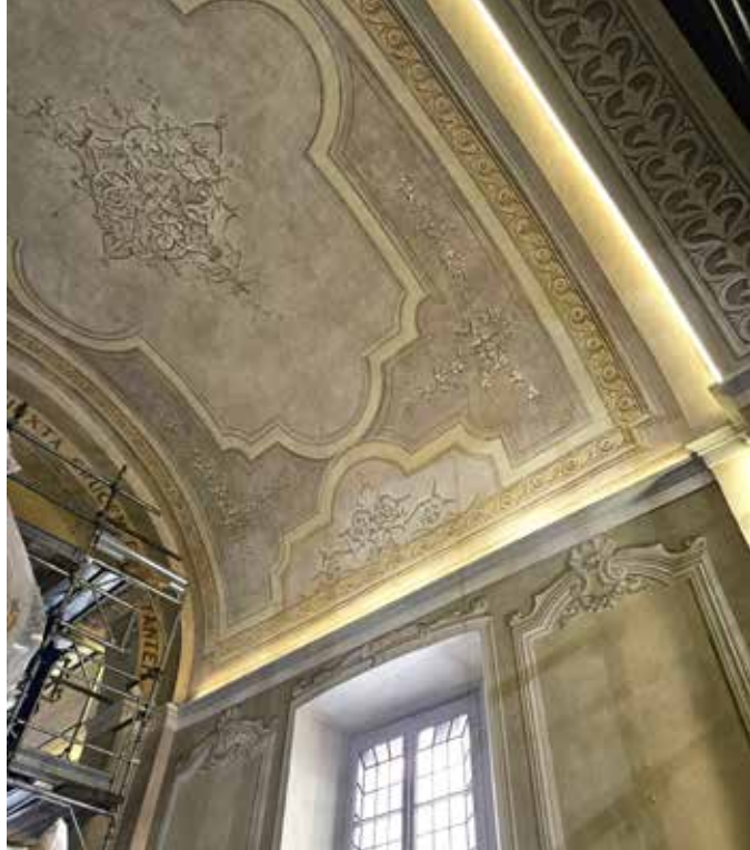
Parete laterale destra, zona altare
