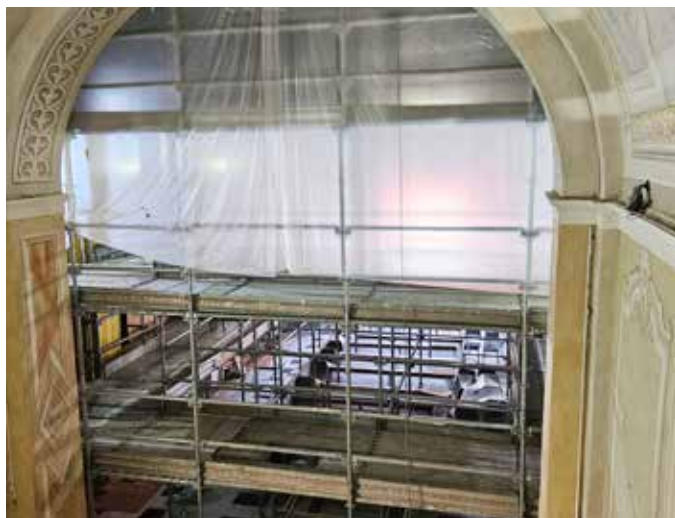
Impalcatura nella navata centrale
