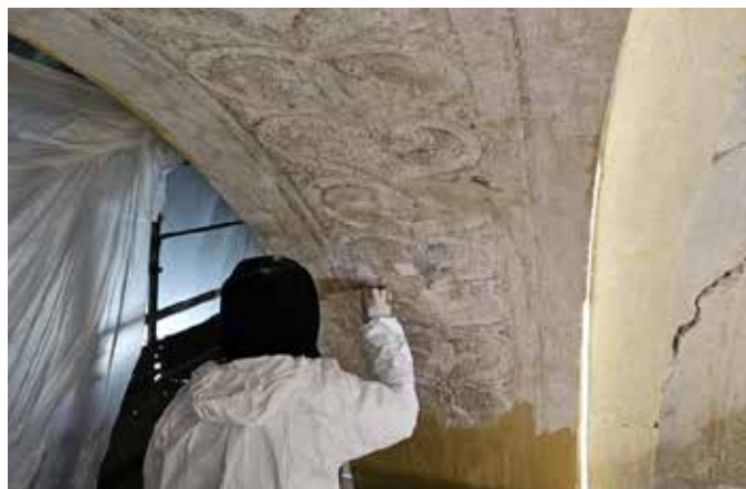
Pulitura della zona dell'arco trionfale
