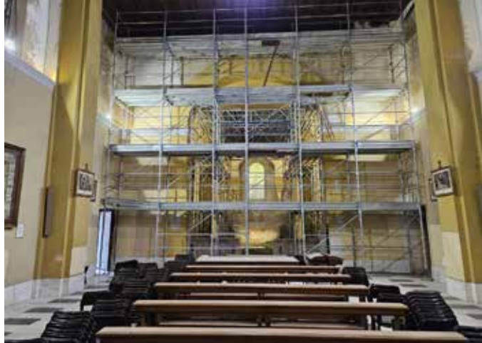
Vista frontale dell'altare con l'impalcato di servizio
