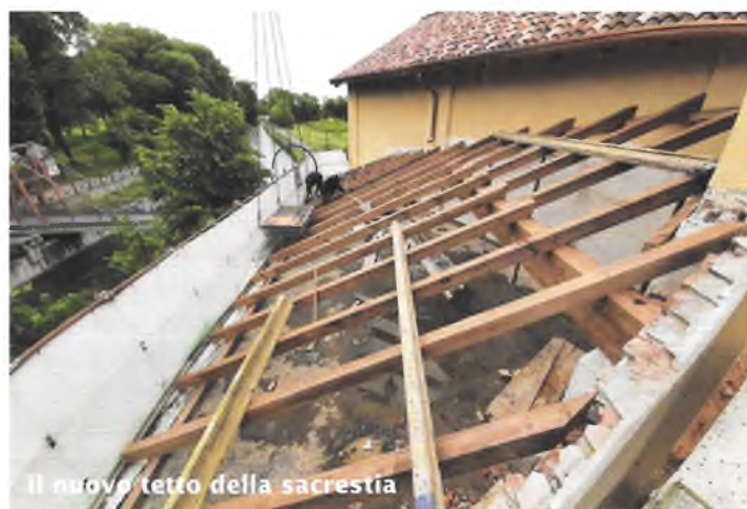
lavori in sacrestia
