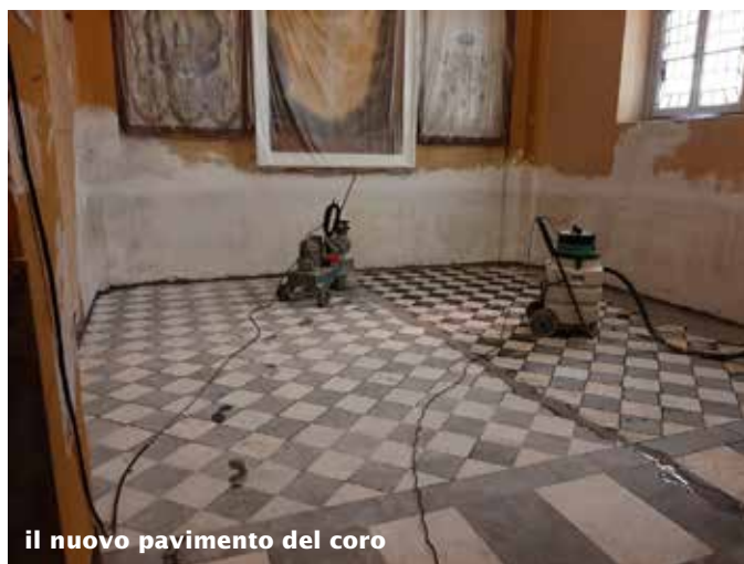
fase iniziale della lucidatura del vasto pavimento
