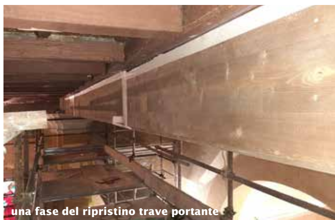
impalcatura interna per il ripristino della trave portante
