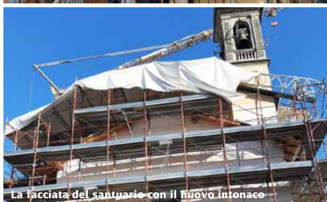
Stesura degli intonaci strutturali sulle murature perimetrali
