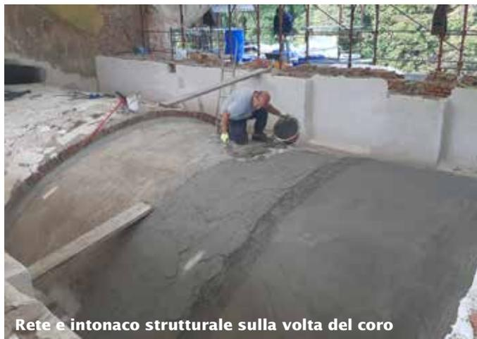
Rete e intonaco strutturale sulla volta del coro
